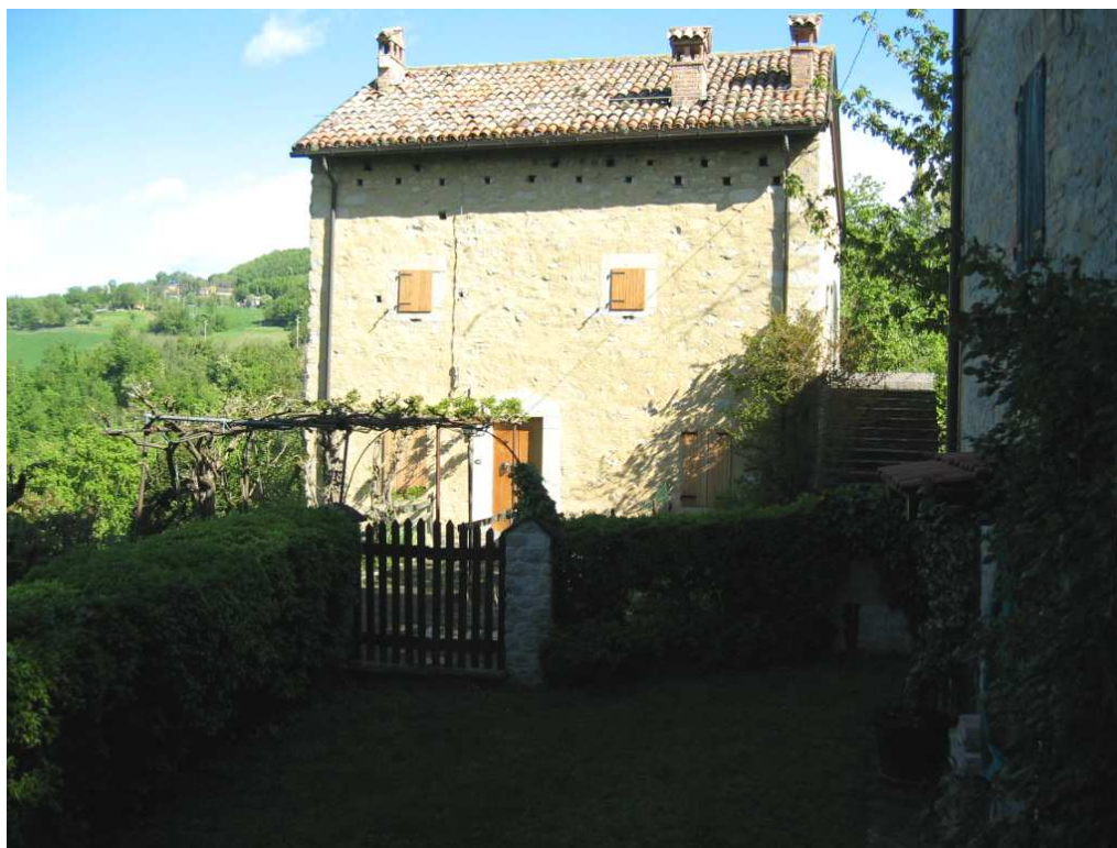
Foto n. 18: Monasterello, casa medievale
